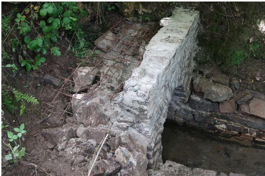
Der hintere Bereich wurde mit Eisenmatten ausgelegt und mit Beton aufgefüllt.
