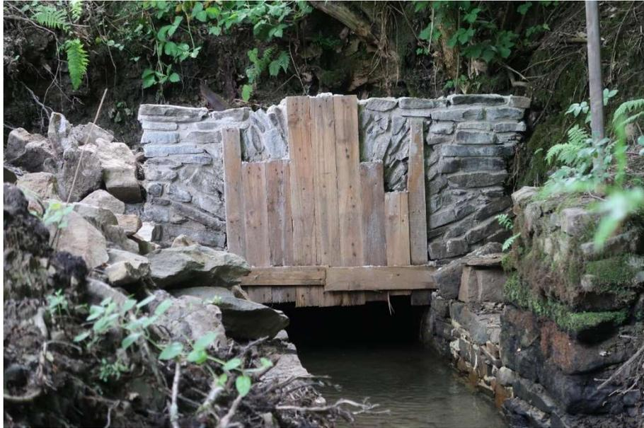
Die Schalung an der Frontseite des Mundlochs wurde entfernt und die restlichen Reihen Bruchsteine aufgemauert.
