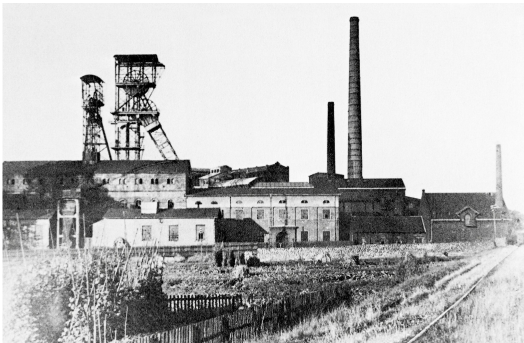
Abb. 7: Schacht 2 (rechts) der Zeche Massen 1920 (Norbert Meier)
