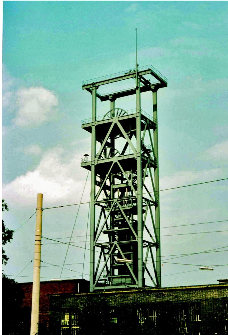
Abb. 12: Schacht 7 der Zeche Minister Stein um 1985. (Heinz und Annemarie Steffler)
