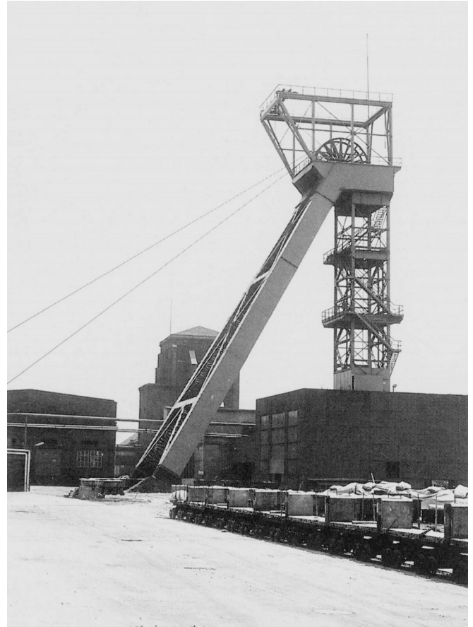
FÜRST HARDENBERG SCHACHT 2 MIT NEUEM FÖRDERGERÜST AB 1966 ZENTRALER MATERIALSCHACHT FÜR MINISTER STEIN / FÜRST HARDENBERG
