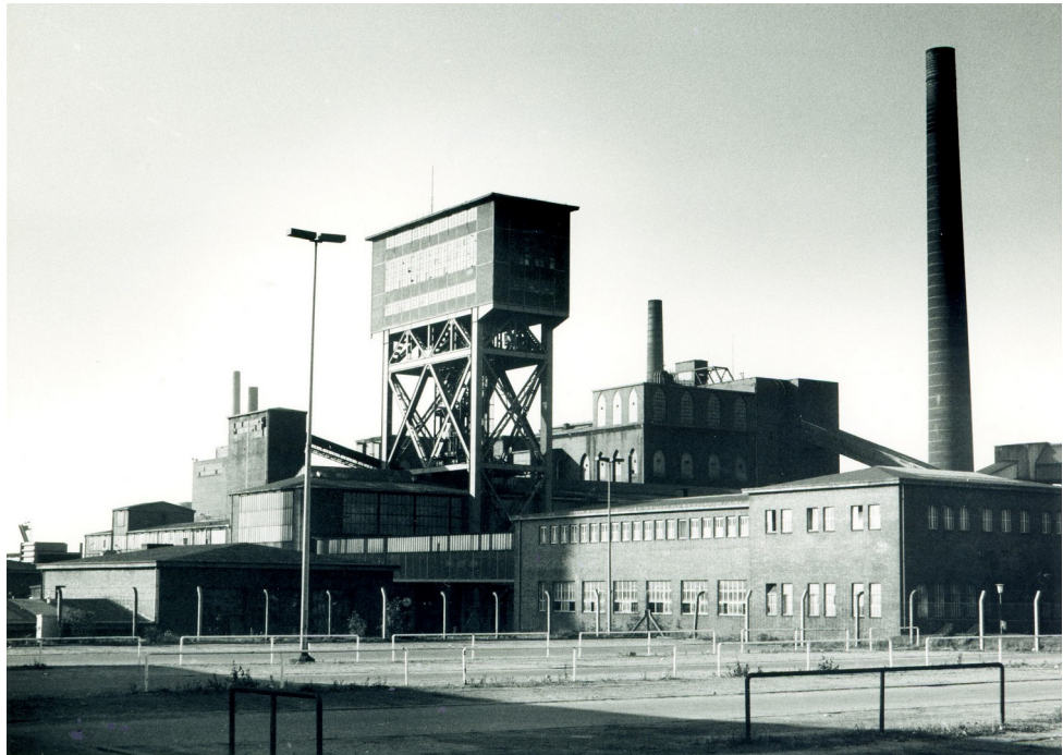
Abb. 10: Schacht 4 (Emil Kirdorf) der Zeche Minister Stein mit Hammerkopfturm, um 1987. (Heinz und Annemarie Steffler)
