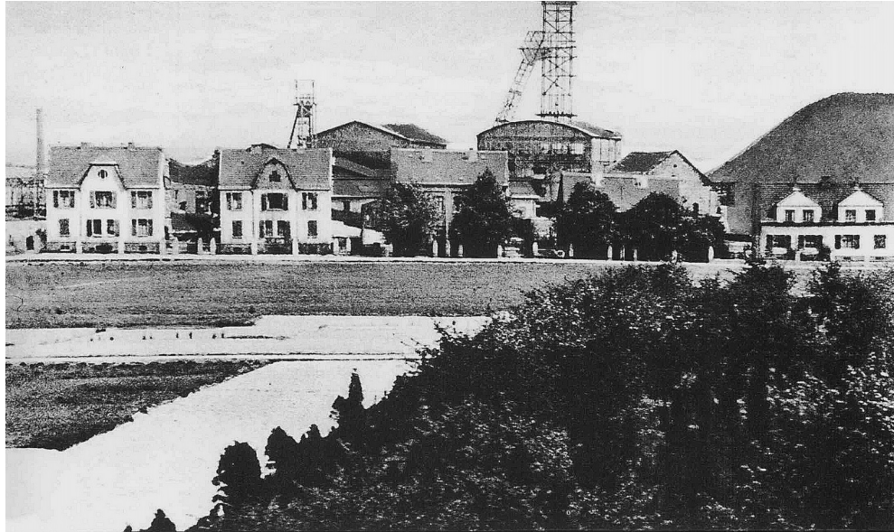
GLÜCKAUF TIEFBAU SCHACHT TRAUGOTT LINKS, SCHACHT GOTTHILF RECHTS UM 1910
