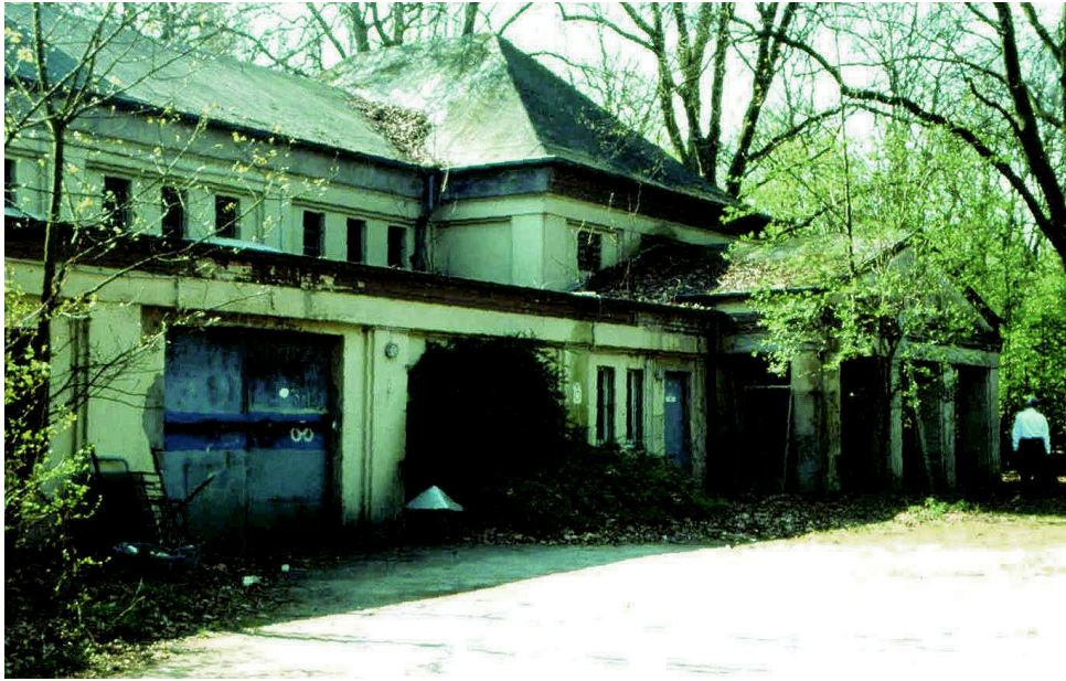
Abb. 22: Schacht 3 (Franz, auch Rathenau genannt) der Zeche Glückaufsegen 3 vor dem Umbau 2007, (Ingrid Cramm)
