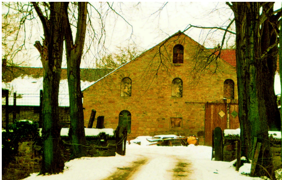
Abb. 7: Schachtgebäude Huyssen als Bauernhof 1990, später zu Wohnungen umgebaut. (Tilo Cramm)
