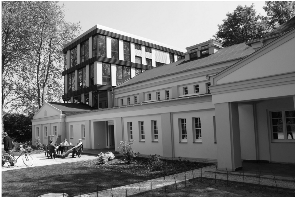
Abb. 23: Schacht 3 (Franz, auch Rathenau genannt) der Zeche Glückaufsegen 3 nach dem Umbau 2010. (Tilo Cramm)
