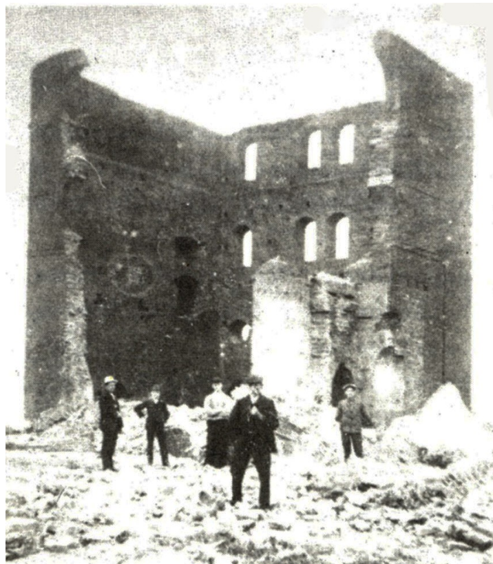
Abb. 2: Schacht Sanssouci der Zeche Henriette (1889 zur Zeche Kaiser Friedrich), 1911 im Abbruch (Karl-Heinz Strothmann)
