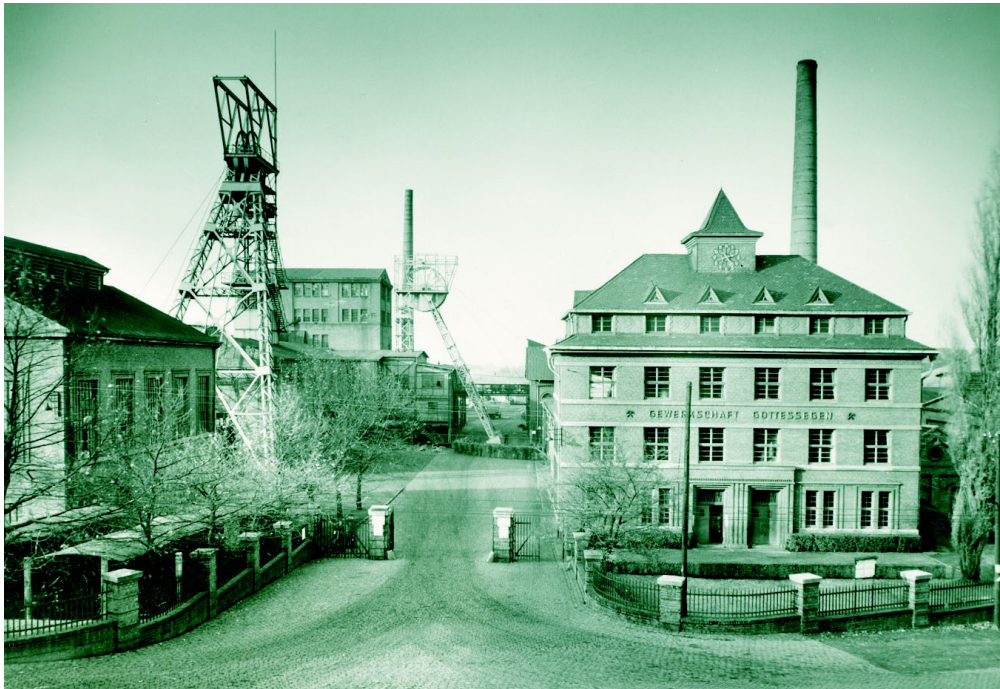
Abb. 18: Schacht 2 (links) der Zeche Gottessegen (hinten Schacht 1) 1950, (Historisches Konzernarchiv RWE, Essen)
