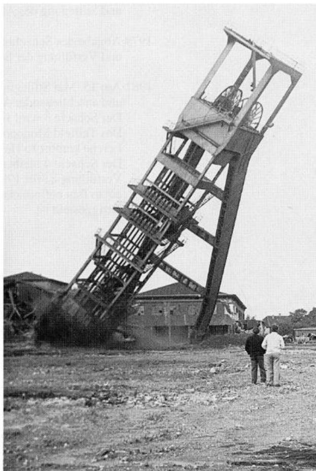
(25) Das Fördergerüst vom Schacht 3 wird umgezogen. Die Übertageanlagen von Königsborn 3/4 wurden nach der Stilllegung bis auf den Schacht 4 eingeebnet.
