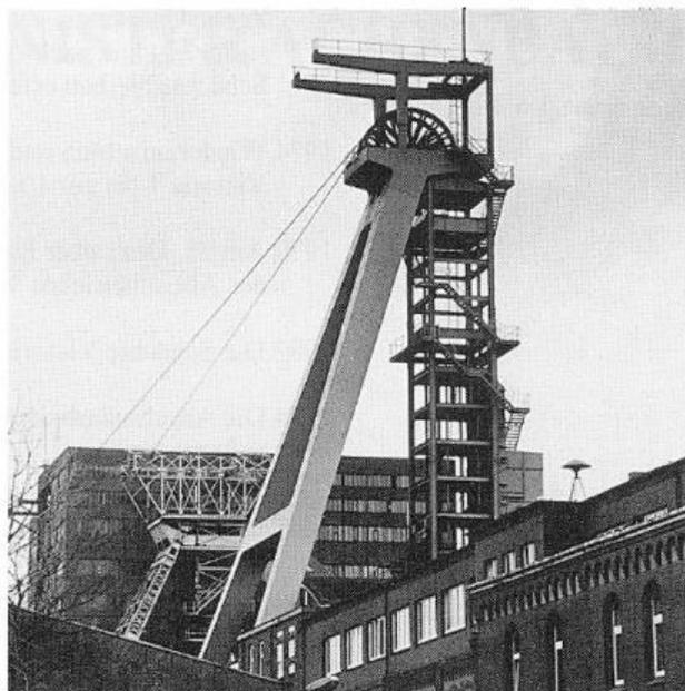
(46) Auf dem Gelände der ehemaligen Zeche Preußen I in Gahmen wurde die Schachanlage Victoria 3/4 ab 1955 neu errichtet. Das Foto zeigt die fertiggestellte Anlage mit den Fördergerüsten 3 und 4 um 1958.
