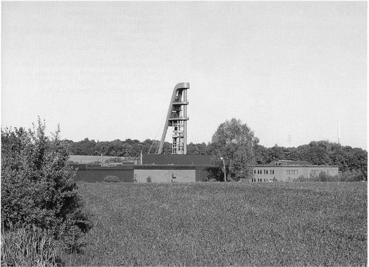
*(40) Ein Musterbeispiel für ein Anschlußbergwerk ist der Seilfahrt- und Materialschacht Haus Aden 7 in Werne-Langern. Die Anlage wurde bereits mehrfach mit Preisen für die architektonische Gestaltung ausgezeichnet.*
