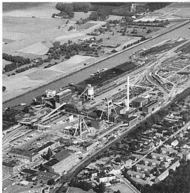
(39) Luftbild der Übertageanlagen der Zeche Haus Aden. Der Schacht 2 erhielt 1979 eine 2. Förderung eingebaut. Das Fördergerüst wurde zu einem Doppelbockgerüst umgebaut. Am oberen Bildrand ist noch der Wetterschacht 5 in Bergkamen-Heil zu erkennen.
