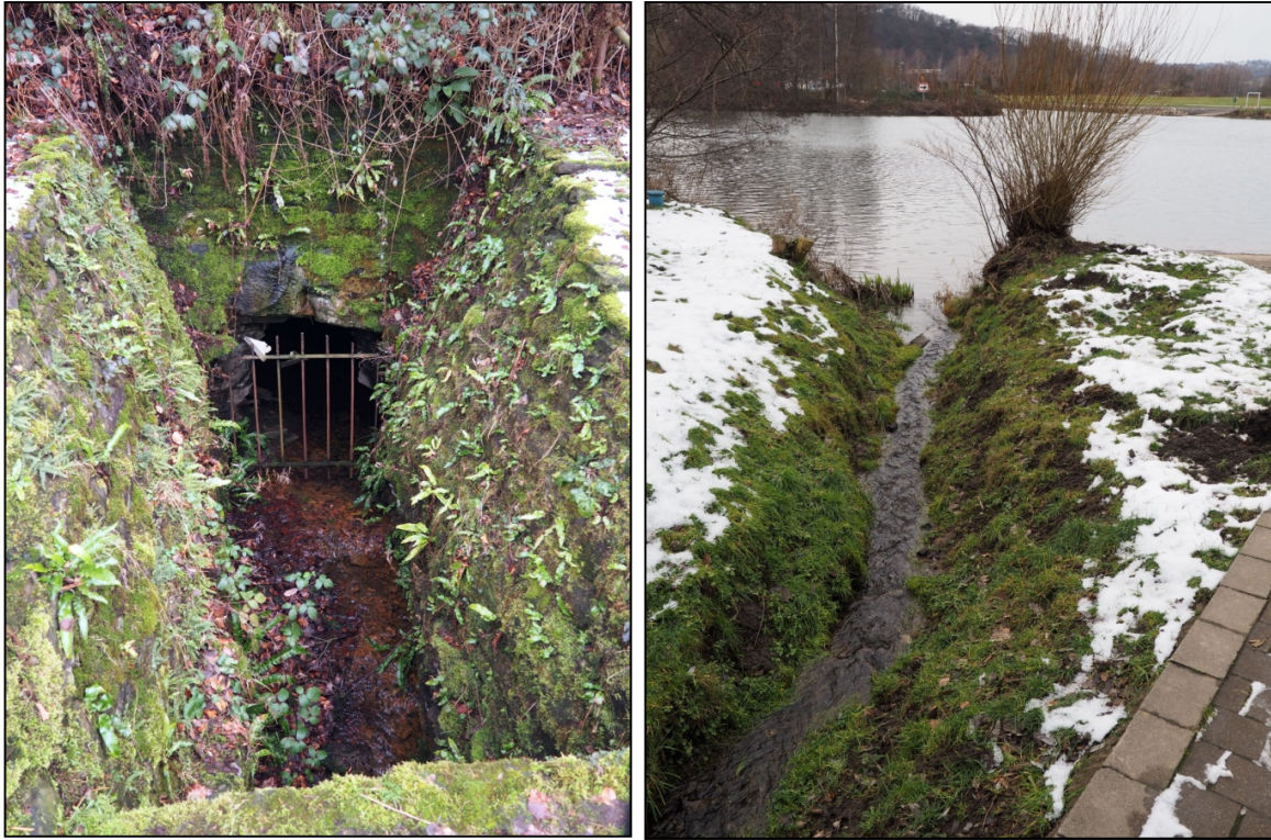
Bild 7 Mundloch (links) und Einlaufstelle Ruhr (rechts) des Vereinigungsstollens in Witten (Schöpel Februar 2019)
