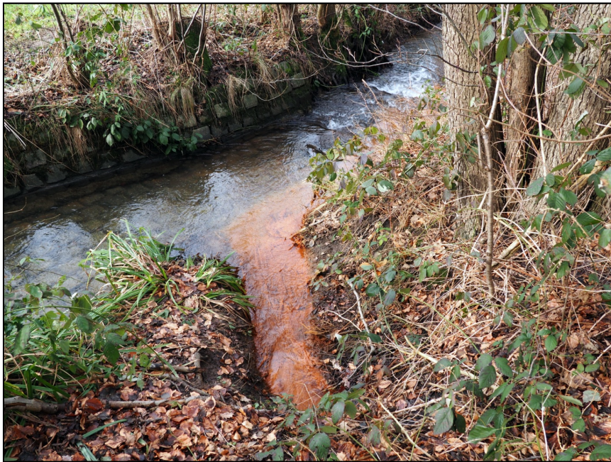
Bild 12 Stollen von Braut mit Einleitestelle im Passbach (Schöpel 2019)
