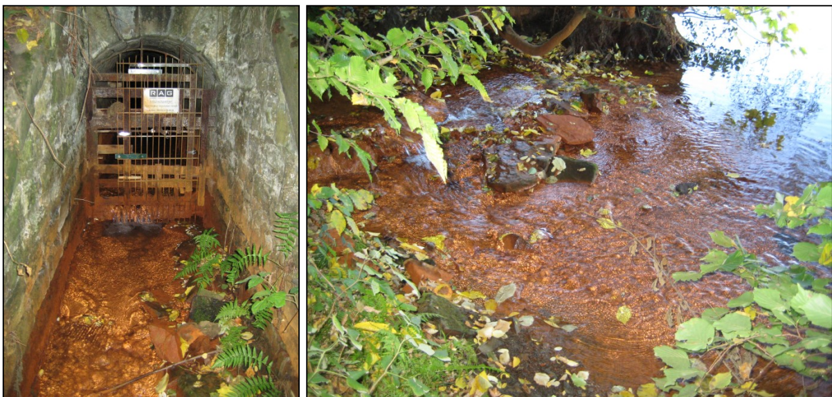
Bild 4 Mundloch (links) und Einmündung in die Ruhr (rechts) des St. Johannes Erbstollens in Witten (Schöpel Oktober 2018)
