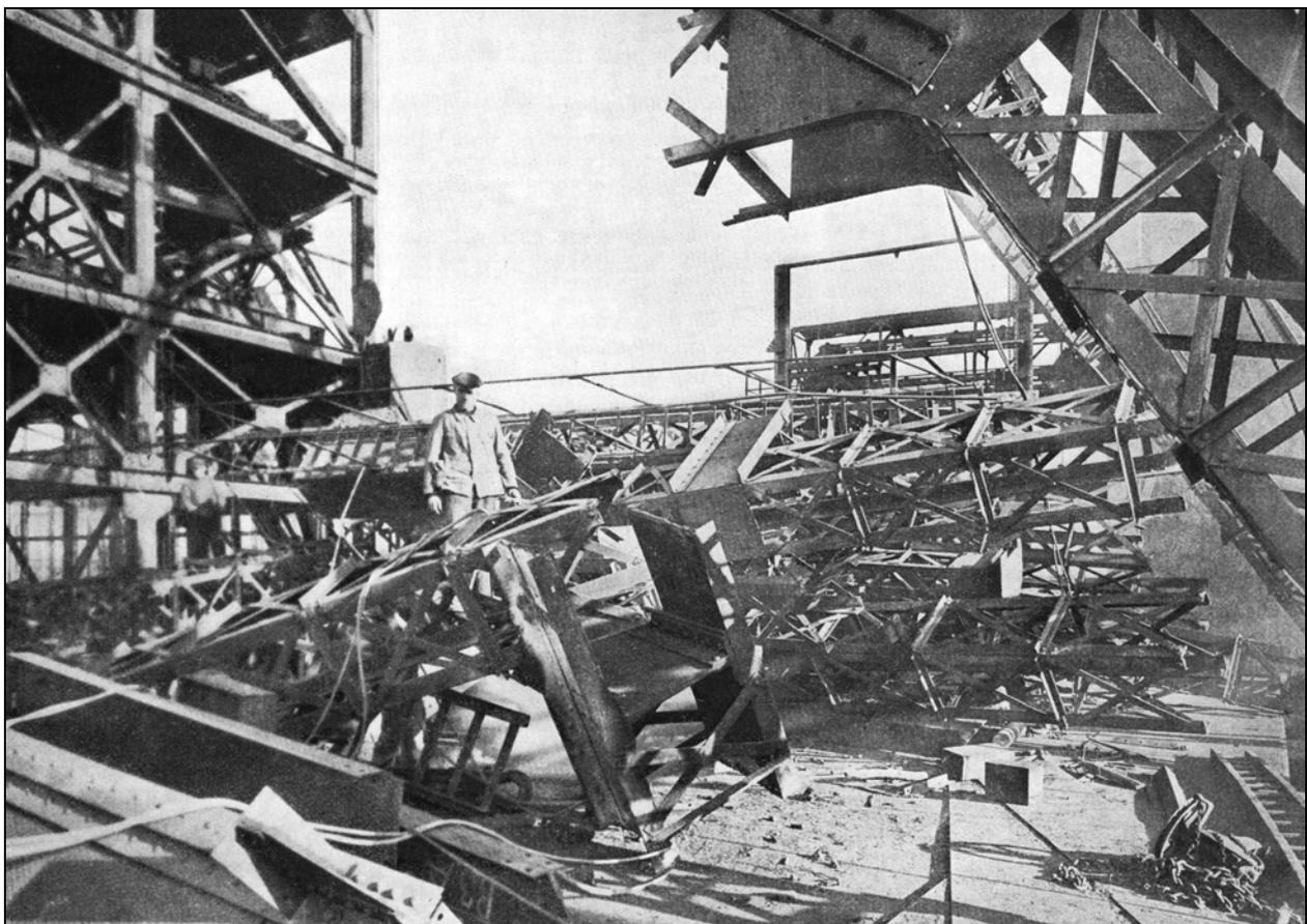
*Abb. 61: Demontage des alten Schachtgerüsts, links das neue Führungsgerüst im Oktober 1927.*
