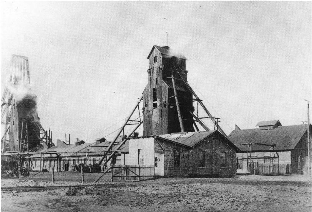
*(30) Während der Teufphase wird an Schacht 1 (links) bereits das Fördergerüst erstellt.*
