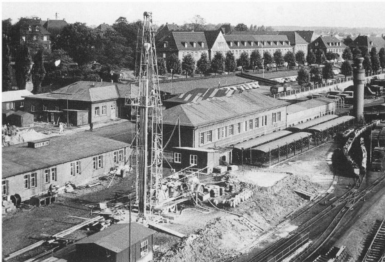
(61) Vorbereitungsarbeiten an der Teufstelle für den neuen Zentralförderschacht 5 (Konrad Ende) 1958.
